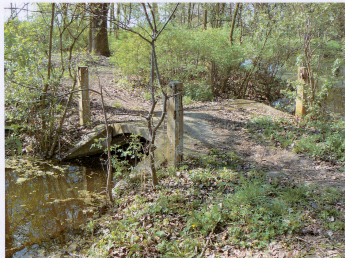
Fot.24. Mostek na południowym stawie. Fot. P. Wilanowski.
