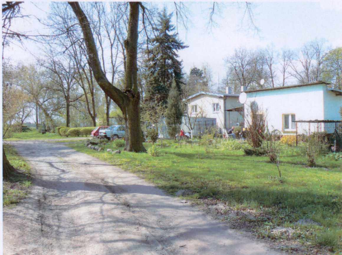
Fot. 17. Południowe elewacje oficyn dworskich przed nimi fragment parku gdzie dawniej zlokalizowany był dwór. Fot. P. Wilanowski
