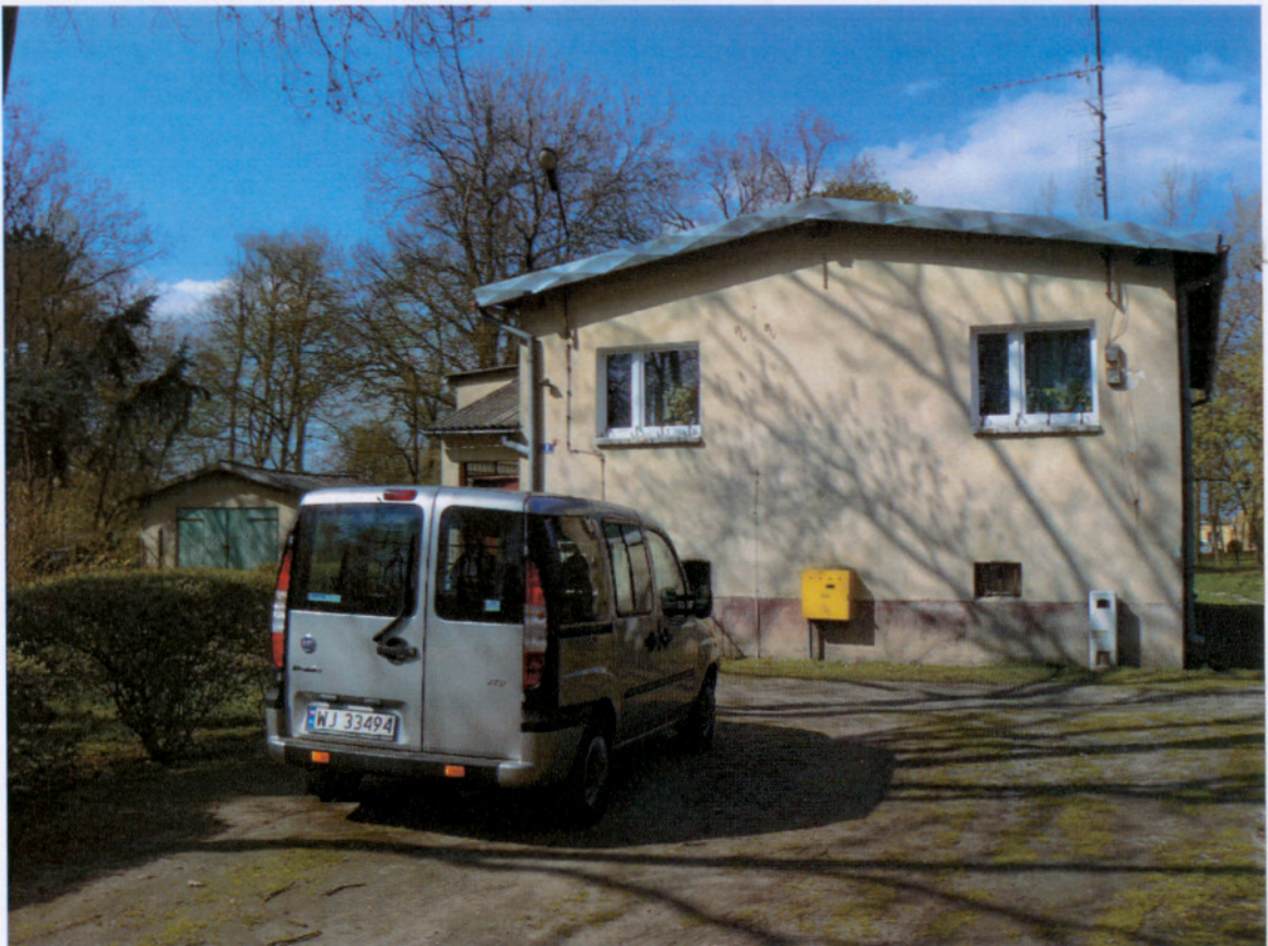
Fot. 20. Zabudowania dworskie – zachodnia oficyna i garaż. Fot. P. Wilanowski.
