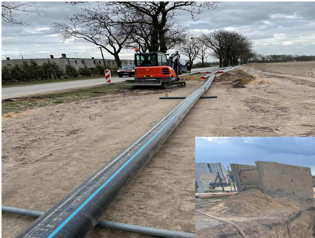
← Budowa rurociągu łłocznego DN 250 z Nagradowic do Komornik i przepompowni ścieków
