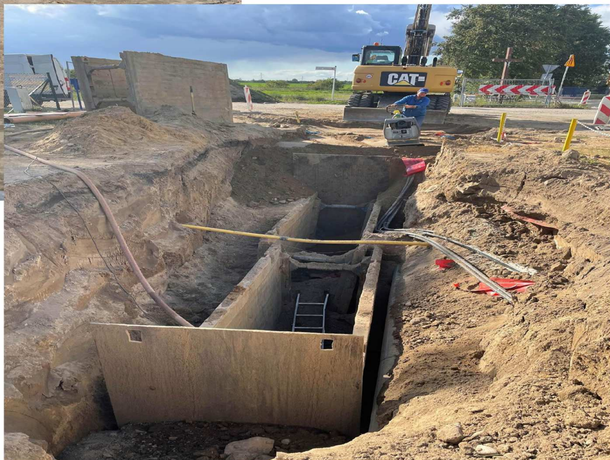
← Budowa rurociągu łłocznego DN 250 z Nagradowic do Komornik i przepompowni ścieków
