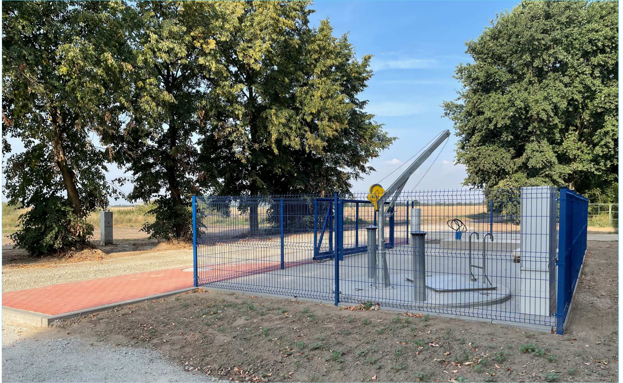
Budowa kanalizacji Komorniki Etap I – odcinek Nagradowice – Komorniki – główna przepompownia ścieków w Komornikach.
