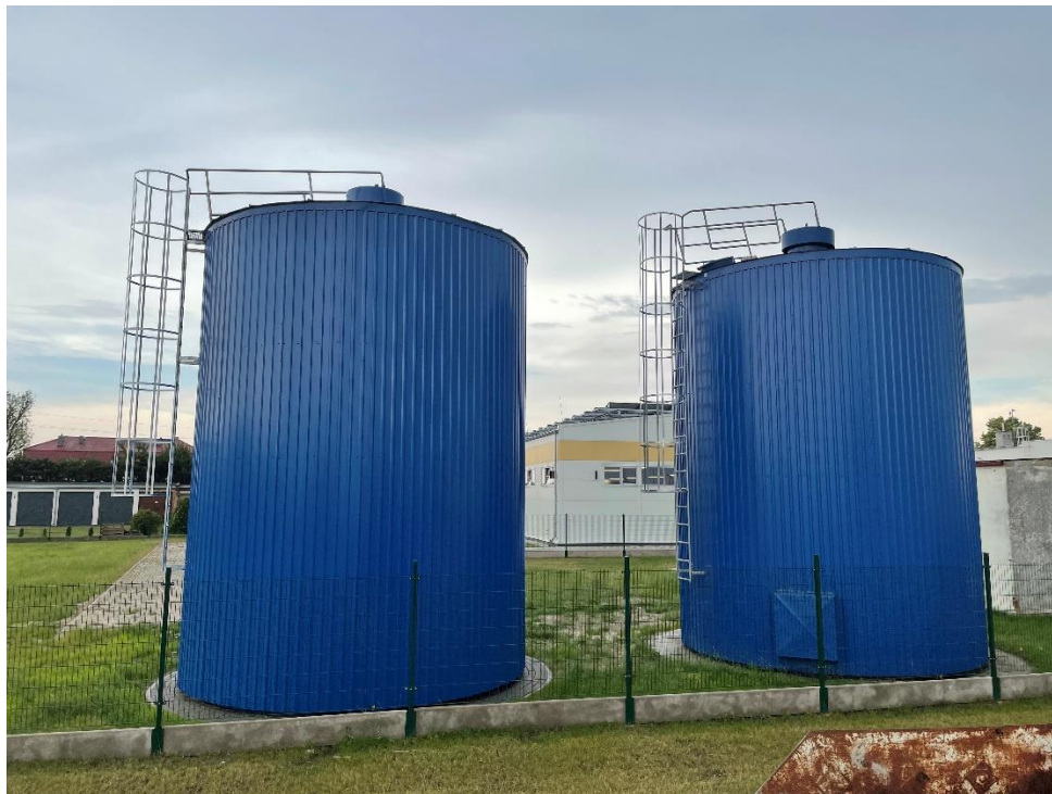
W SUW w Kleszczewie zamontowano drugi zbiornik retencyjny
