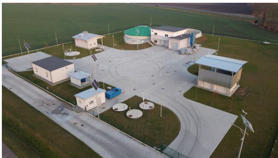
Oczyszczalnia ścieków w Nagradowicach
