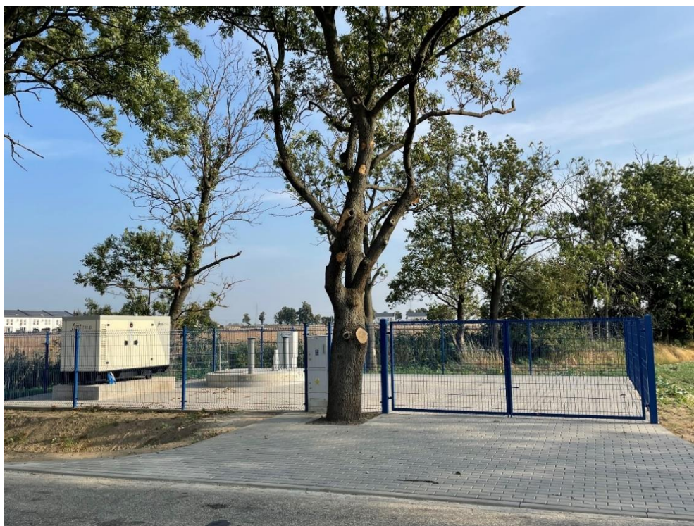
Nowa przepompownia ścieków na kolektorze Komorniki-Nagradowice
